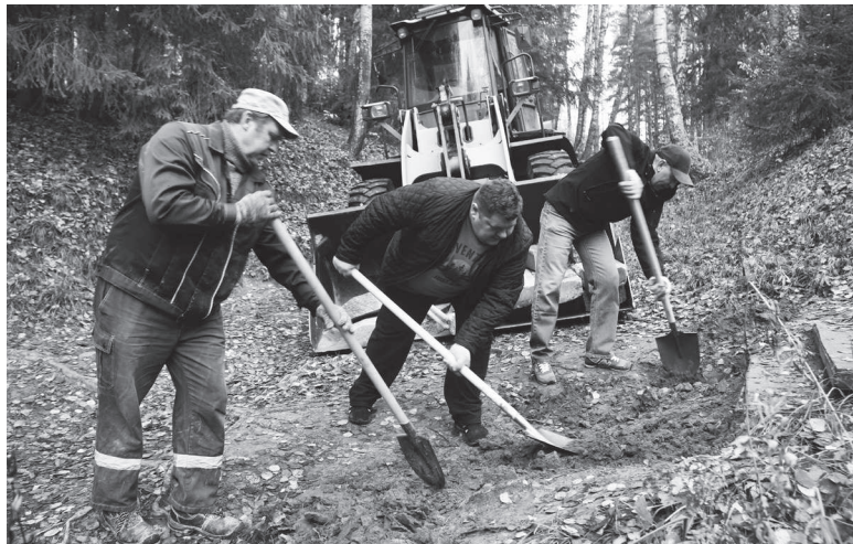
Работы в районе лестничного спуска к родничкам.
