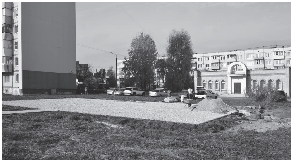
Строительство площадки для игры в настольный теннис возле дома №4 в 3-м квартале.
