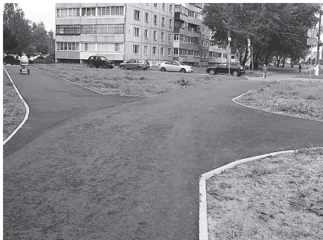
Участок пешеходной дорожки сзади остановки за домом № 18 в первом квартале после проведения ремонтных работ.
