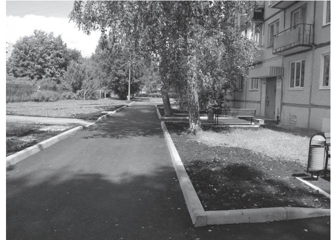
Придомовая территория у дома № 12 первого квартала после благоустройства.
