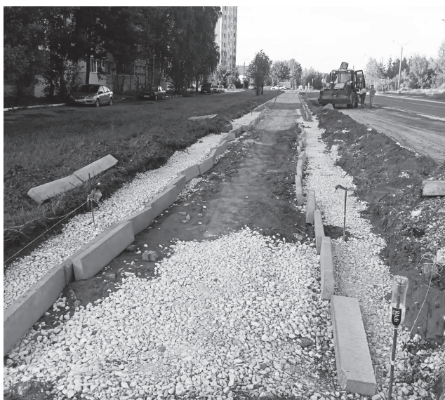
Работы по устройству пешеходной дорожки от ТЦ «Дельфин» в сторону жилого дома №10 третьего квартала ведутся подрядчиком ООО «Автодорстрой».
