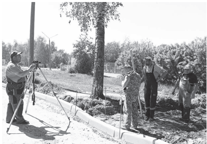
Работы у дома №12.
