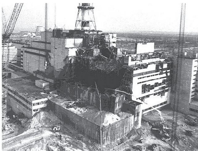
Разрушенный реактор ЧАЭС.
